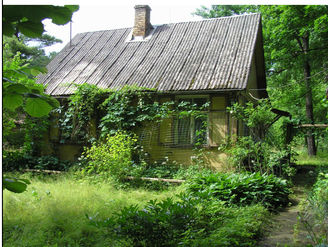
Detālplānojuma teritorija – apbūve Krišjāņa Valdemāra ielā 16, dienvidu fasāde
