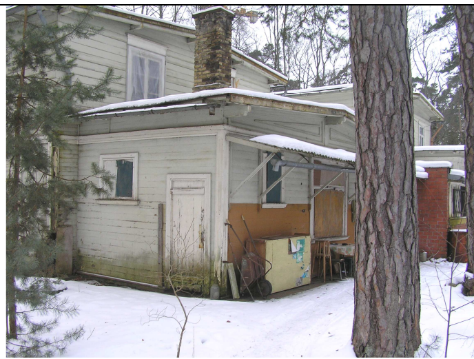
Ēkas ziemeļu fasāde, skats no Gulbenes ielas
