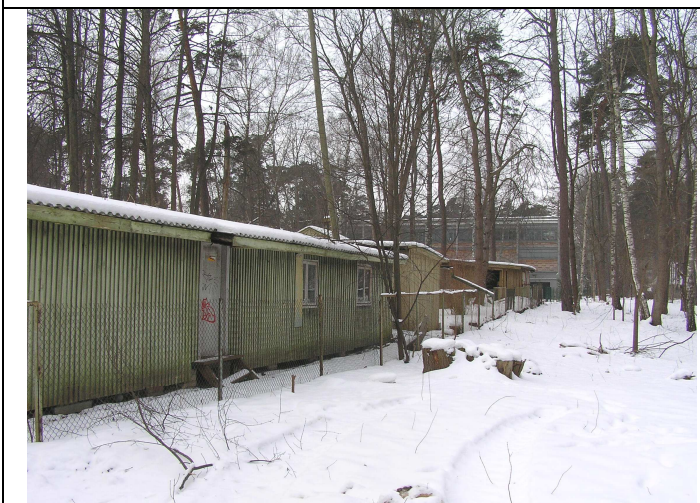
Saimniecības ēkas pie zemesgabala ziemeļu robežas, skats no ziemeļiem
