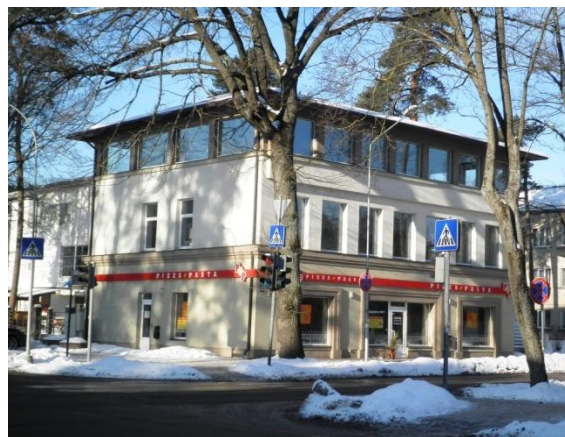
Vienības prospekts 6. Esošā 3 stāvu apbūve Vienības prospekta un Meža prospekta krustojumā. Apbūve atrodas Valsts nozīmes pilsētībūvniecības pieminekļa teritorijā.
