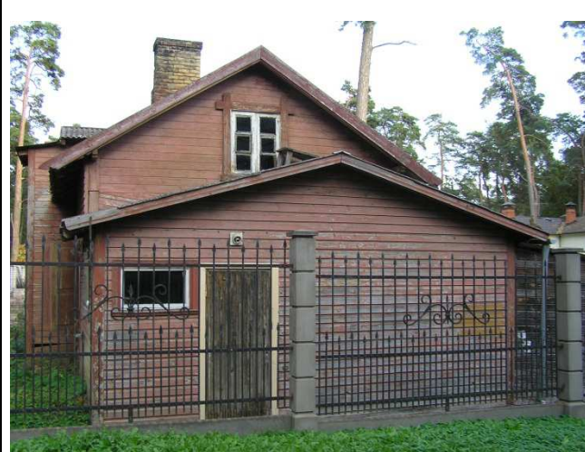
Dzīvojamā ēka Bērzaunes ielā 1, Rekonstruējamā ēka
