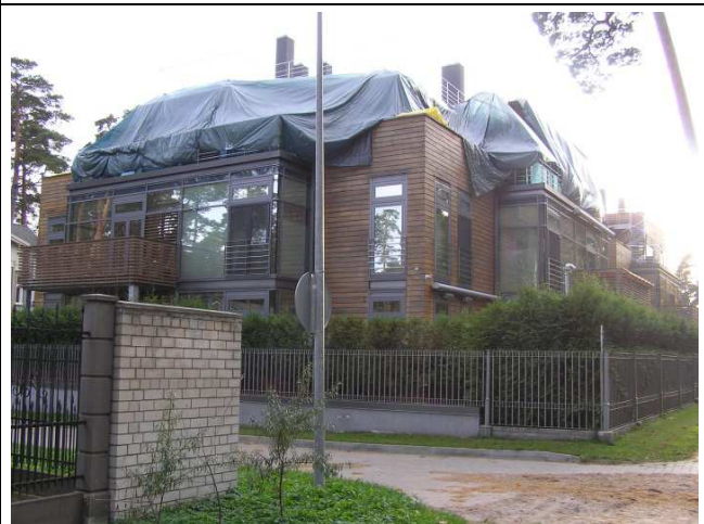
Zemesgabala Dzintaru prospektā 39 apbūve pie Bērzaunes ielas un plānotā veloceļa pretī detālpārplānojuma teritorijai
