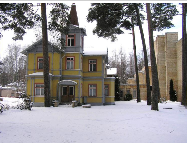
Zemesgabalā esošā ēka kad.nr.13000081609008
