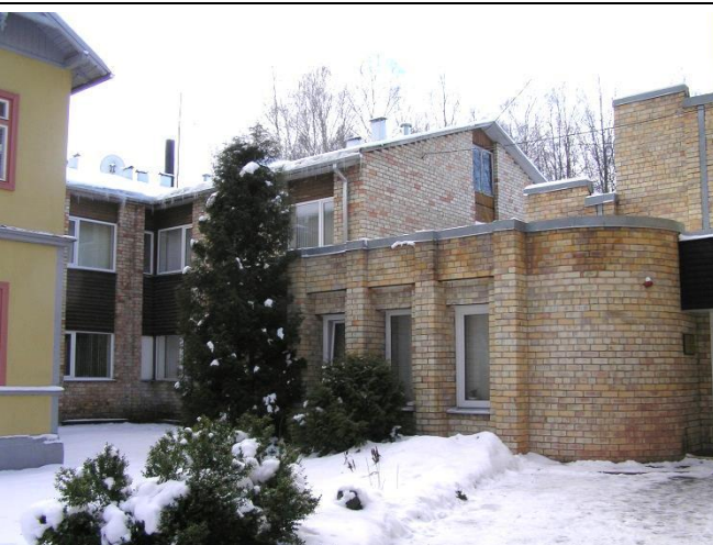
Zemesgabalā esošā ēka kad.nr.13000081609003
