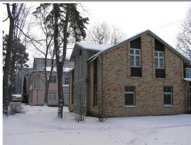
Zemesgabalā esošā ēka kad.nr.13000081609011
