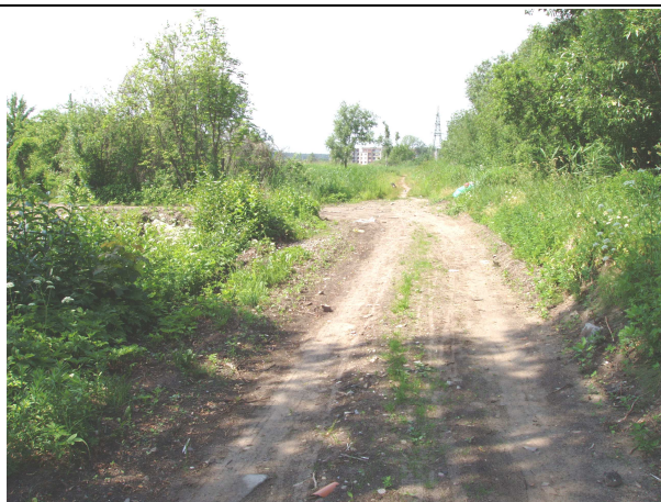
Palienes ielas un Promenādes ielas turpinājuma krustojums
