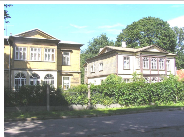
Blakus esošā apbūve Pils ielā
