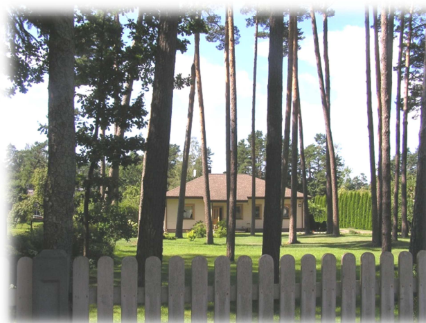
Apbūve blakus detālplānojuma teritorijai Valtera prospektā 16B
