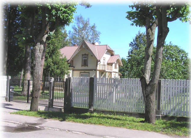
Apbūve Valtera prospektā, pretī detālplānojuma teritorijai
