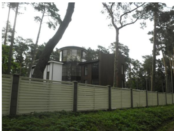
Esošā apbūve (jaunbūve) Kāpu iela 77
