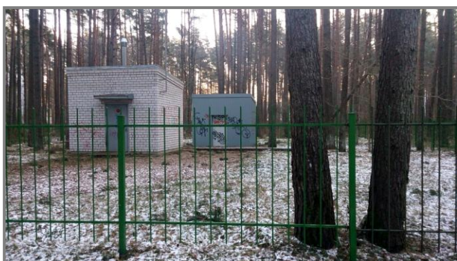
10.Attēls.Sūkņu māja un artēziskā aka detālplānojuma teritorijā.
