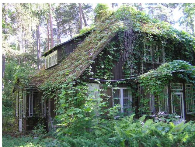
Dzīvojamā ēka 20.līnijā 2 kad.Nr.13000042102001 Ēkas rietumu fasāde
