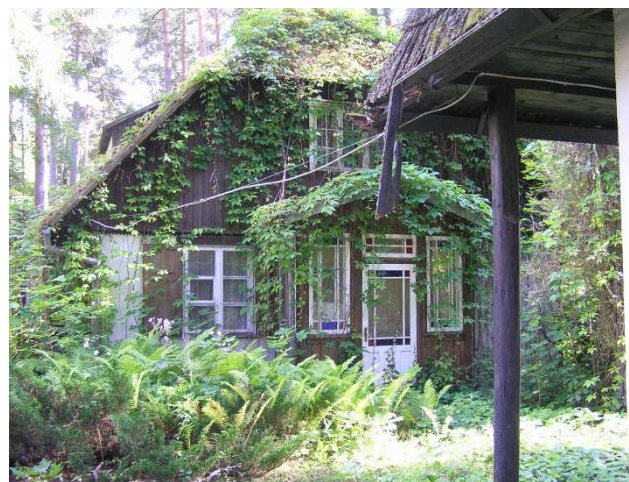
Dzīvojamā ēka 20.līnijā 2, kad.Nr.13000042102001, ziemeļu fasāde
