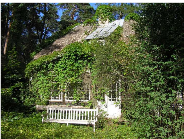
Ēkas rietumu fasāde
