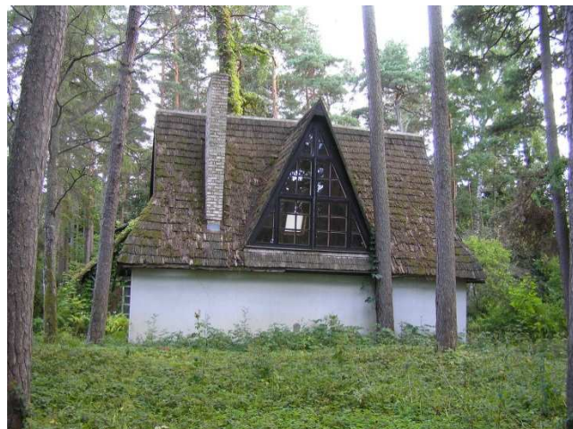
Saimniecības ēka 20.līnijā 2, Ziemēļu fasāde
