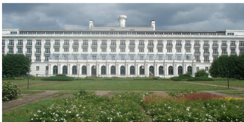
Attēls Nr.51: Viesnīca „Baltā pils” (foto P.Grants 07.2013.)
