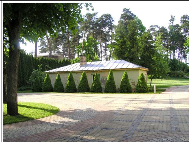
Detālplānojuma teritorijā esošā ēka kad.Nr.13000091802005
