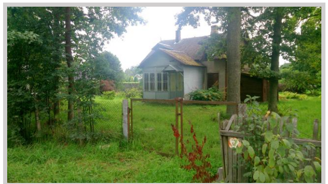
8.Attēls. Detālplānojuma teritorijā esošā ēka pie Tālvaiža ielas.
