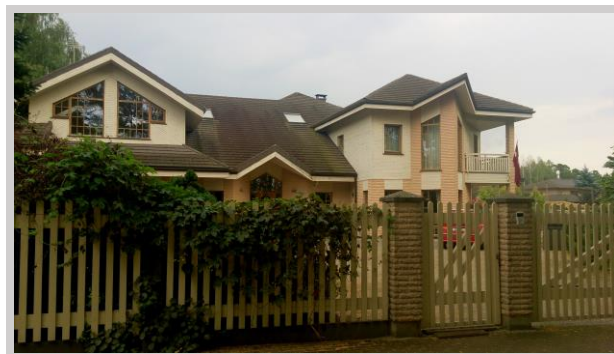
8.Attēls. Detālplānojuma teritorijai apkārt esošā apbūve.
