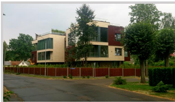
7.Attēls. Detālplānojuma teritorijai apkārt esošā apbūve.
