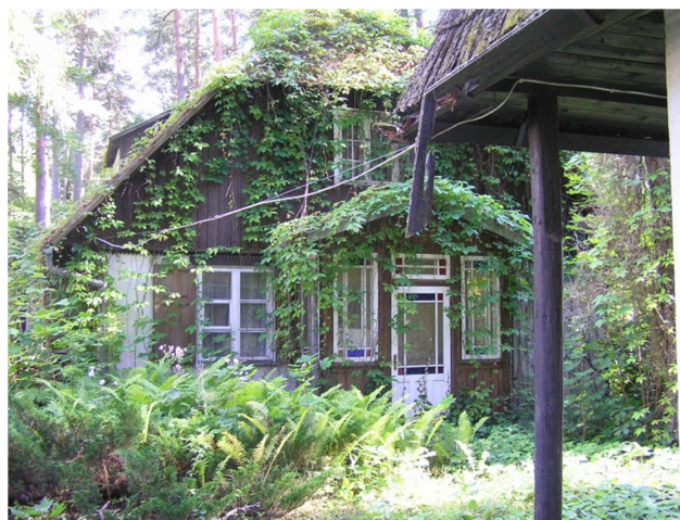
Dzīvojamā ēka 20.līnijā 2, kad.Nr.13000042102001, ziemeļu fasāde
