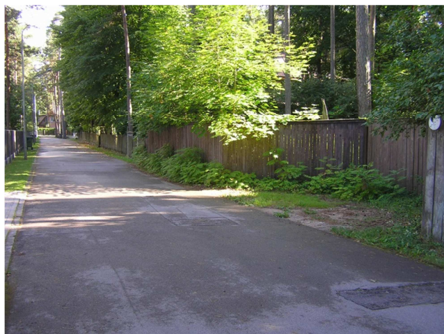
Esošā iebrauktuve zemesgabalā
