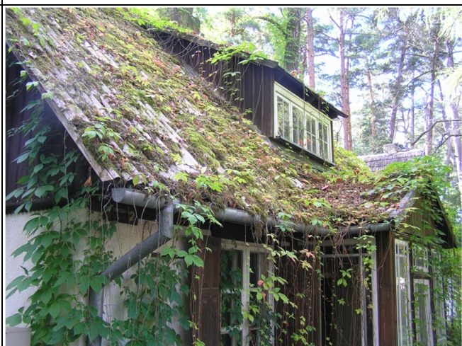
Dzīvojamās ēkas jumta izbūve
