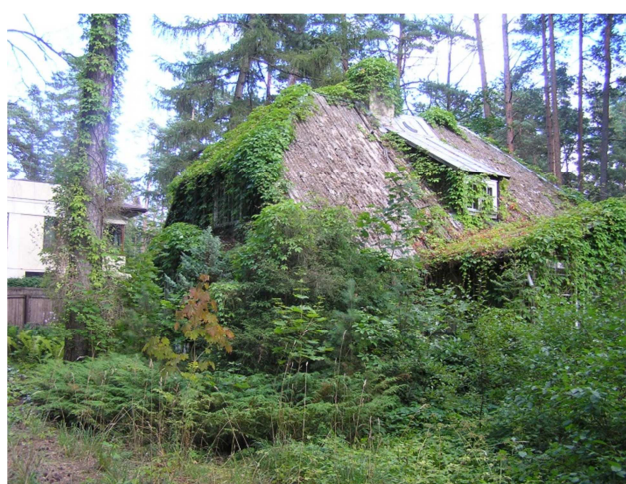
Skats uz ēku no ziemeļrietumiem
