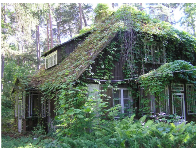
Dzīvojamā ēka 20.līnijā 2 kad.Nr.13000042102001 Ēkas rietumu fasāde
