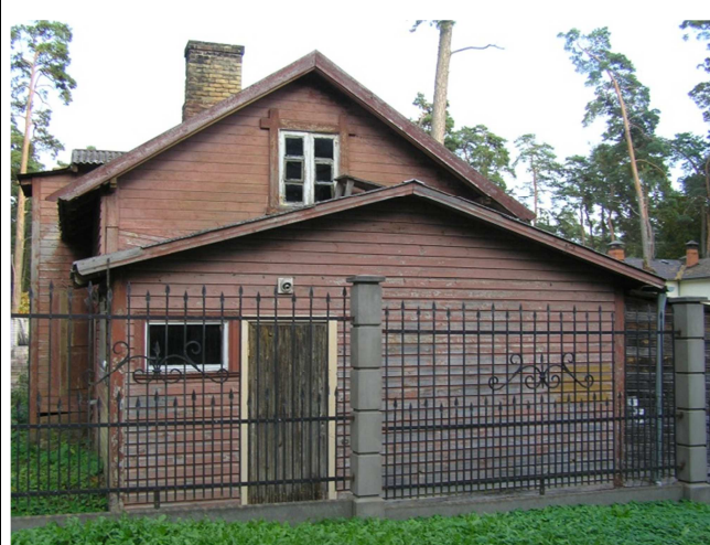
Dzīvojamā ēka Bērzaunes ielā 1, Rekonstruējamā ēka
