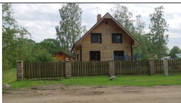
Apbūve Pļaviņu ielā 4
