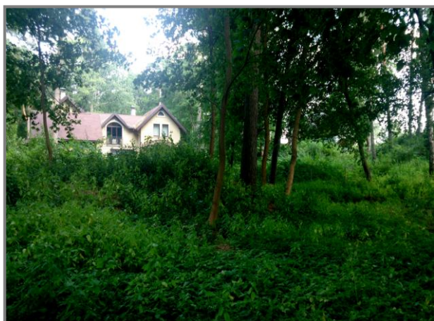
7.Attēls. Detālpilānojuma teritorija un tai blakus esošā apbūve.
