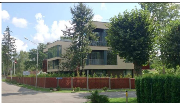
Kāpu iela 106 – apbūve pretī detālplānojuma teritorijai
