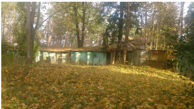
20.attēls. Ēka ar kadastra apzīmējumu 1300 008 1401 005. Ēka nojaucama.
