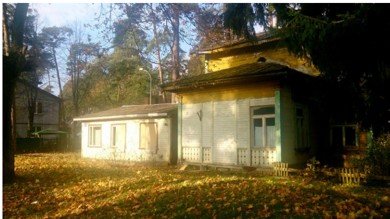
19.attēls. Ēka ar kadastra apzīmējumu 1300 008 1401 001. Ēka nojaucama.
