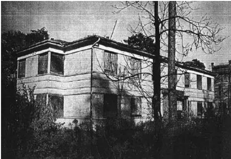
7.attēls. Ēka zemesgabalā Jūras ielā 1, pirms nojaukšanas, 2012.gads (foto SIA "Evolvente")
