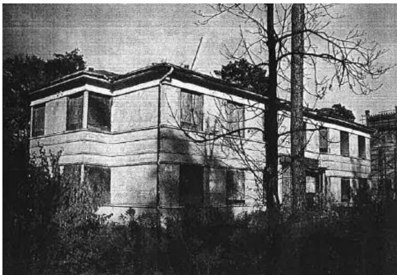
9.attēls. Ēka zemesgabalā Jūras ielā 1, pirms nojaukšanas, 2012.gads (foto SIA "Evolvente")
