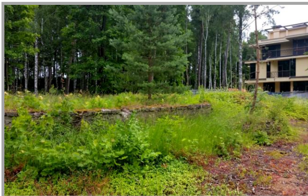
9.Attēls. Detālplānojuma teritorija, teritorijā esošie ēku pamati.
