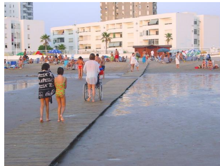
Attēls nr. 98. Koka klājs salikts no posmiem pieejamības nodrošināšanai ( http://en.beach-trotters.com/modular-structures-showers-amp-footbath-details-p-stainless-steel-shower-t-475 )
