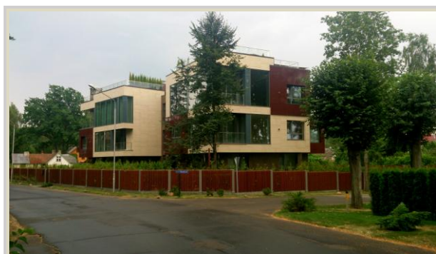
14.Attēls. Detālplānojuma teritorijai apkārt esošā jaunā apbūve. Kāpu iela 106.
