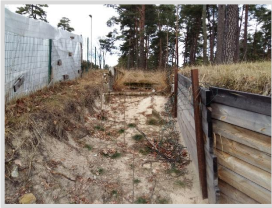
23.Attēls. Detālplānojuma teritorijā esošā atbalsta siena ar kāpnēm.
