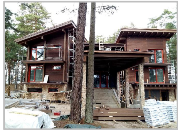
17.Attēls. Detālplānojuma teritorijas ziemeļu daļa - jaunbūve.
