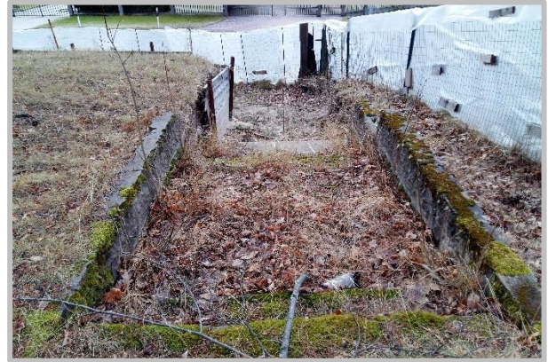
24.Attēls. Detālplānojuma teritorijā esošā atbalsta siena ar kāpnēm.
