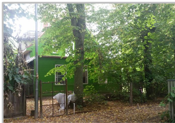
9.Attēls. Skolotāju ielā 7 esošā apbūve.
