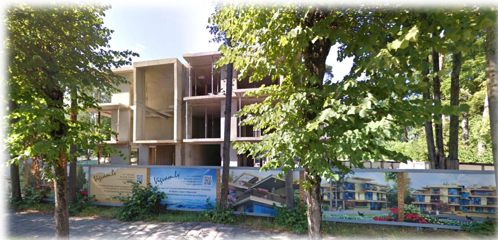
Blakus zemesgabalam Dzintaru prospektā 23, Jūrmalā notiek būvniecība saskaņā ar apstiprināto detālplānojumu.
