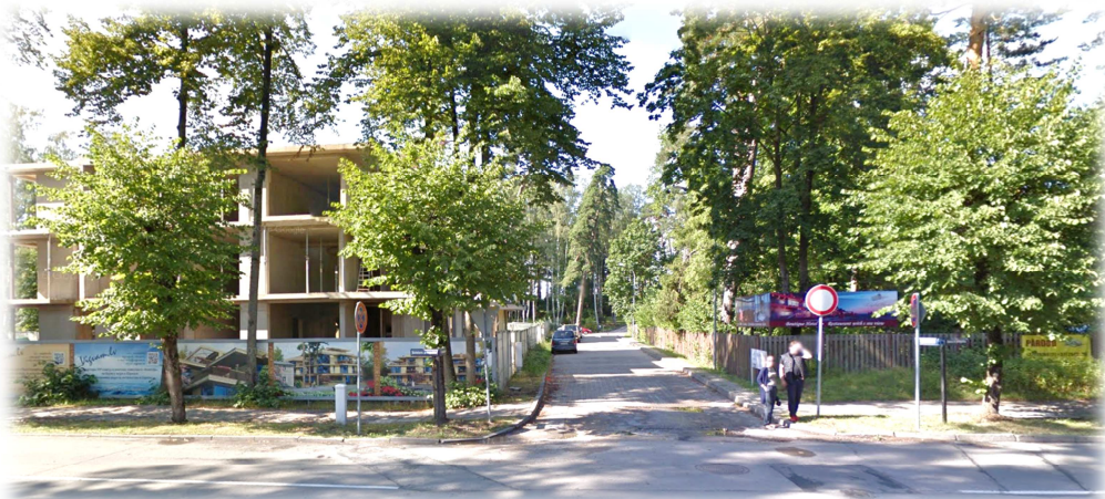
Detālplānojuma teritorijas rietumu pusē izbūvētā Gulbenes iela. Skats no Dzintaru prospekta uz ziemeļiem.
