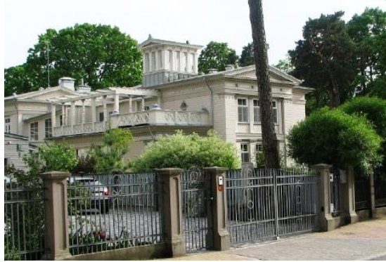
15.attēls. Dzīvojamā ēka Jūras ielā 2, Jūrmala. Neoklasicisma koka būve, arhitektūras piemineklis (aizsardzības nr. 5494). Ēka celta 1909.gadā, rekonstrukcija veikta 1997.gadā.
