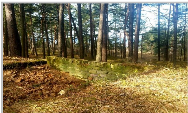
16.attēls. Detālplānojuma teritorijā esošie mūra pamati.
