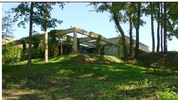
Esošās pergolas zemesgabala DR daļā Pūpolu ielā 1, Pārbūvējamā ēkas daļa
