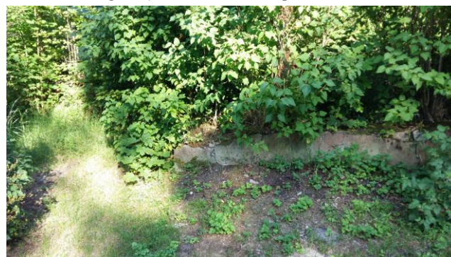
Foto Nr.4. Zemesgabalā Kaugurciems 20A, Jūrmalā, esošie pamati. 2016.gada 1.jūlijs
