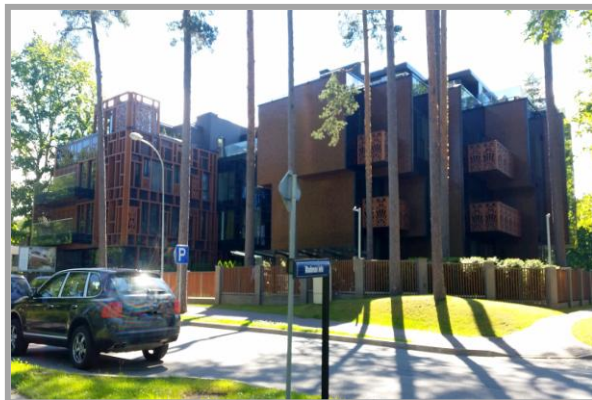
18.Attēls. Apbūve zemesgabālā Dzintaru prospektā 32. Zemesgabalam 2008.gada 27.marta tika apstiprināts detālplānojums (saistošie noteikumi Nr.24). Zemesgabala apbūve realizēta atbilstoši detālplānojuma risinājumiem.
