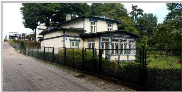
6.Attēls. Apbūve zemesgabalā Zigfrīda Meirovica prospektā 41.
