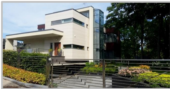
8. Attēls. Detālplānojuma teritorijā esoša apbūve.
