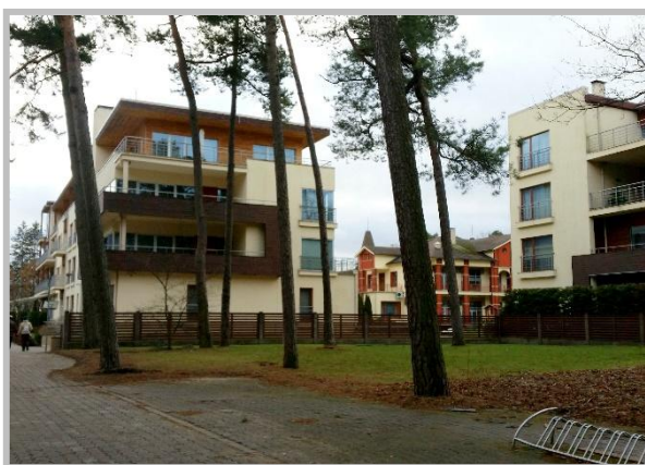
7.attēls. Daudzfunkcionāla ēka zemesgabalā Bulduru prospektā 33 k-2.
