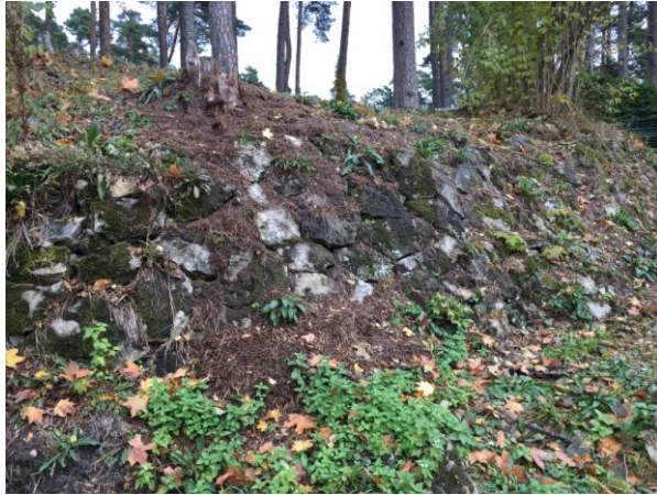
4., 5. attēls. Terasveidīgs kāpas stiprinājums
