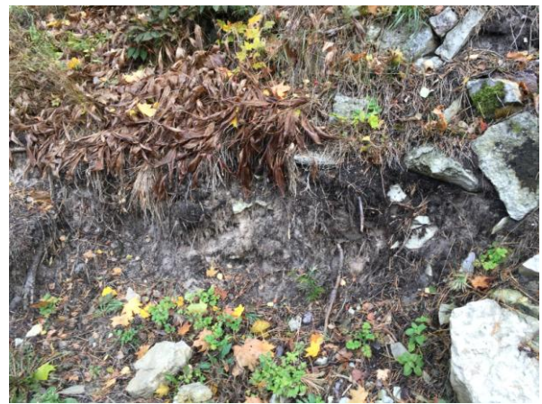
6., 7. attēls. Pēc lietusgāzēm izskalatā kāpas nogāze. Attēlā redzams, ka daļa kāpas nogāzi veido „būvgruži”.
