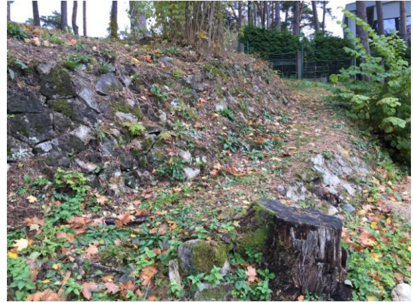
4., 5. attēls. Terasveidīgs kāpas stiprinājums
