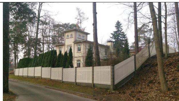
Zemesgabala „A” daļa (1000 m 2 ) un esošā rekonstruētā dzīvojamās ēkas Upes ielā 2, k-1, kadastra apzīmējums 1300 014 2206 001, skats no Upes iela
