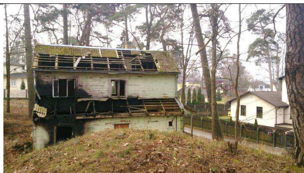
Skats no ziemeļu puses uz esošo ēku Upes ielā 2, kadastra apzīmējums 1300 014 2206 002
