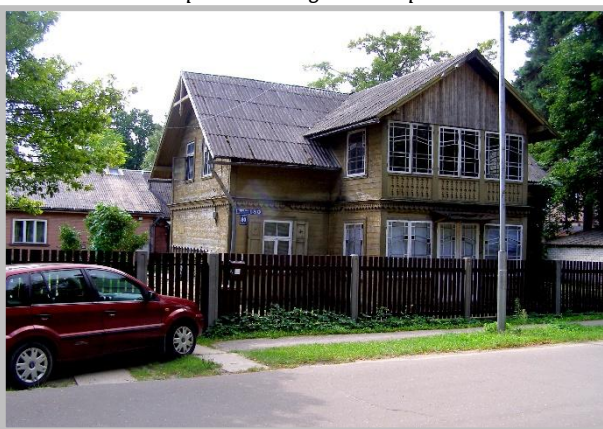
10.attēls. Apbūve zemesgabalā Kāpu ielā 80.
