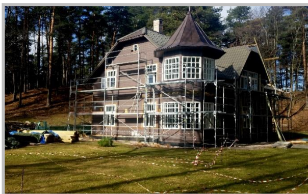
18.attēls. Detālplānojuma teritorijā esošā dzīvojamā ēka.
