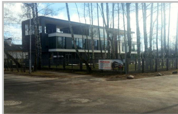
7.attēls. Apbūve zemesgabalā Kāpu ielā 74.
