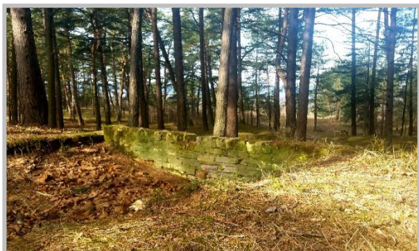
16.attēls. Detālplānojuma teritorijā esošie mūra pamati.
