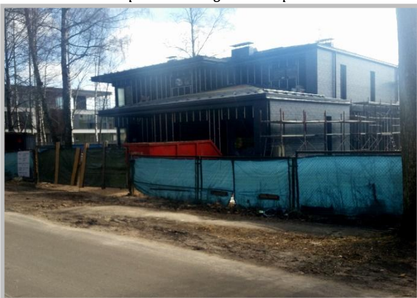
8.attēls. Apbūve zemesgabalā Kāpu ielā 76.
