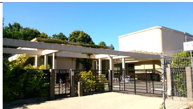
Apbūve Pūpolu ielā 1, skats no Emelīnas ielas, esošā transporta piebraukšana zemesgabalam
