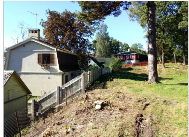
3. attēls. Skats uz detālplānojuma teritorijas reljefa paaugstinājumu un teritorijas dienvidu robežai pieguļošo apbūvi. Nepieciešami pasākumi kāpas stiprināšanai.
