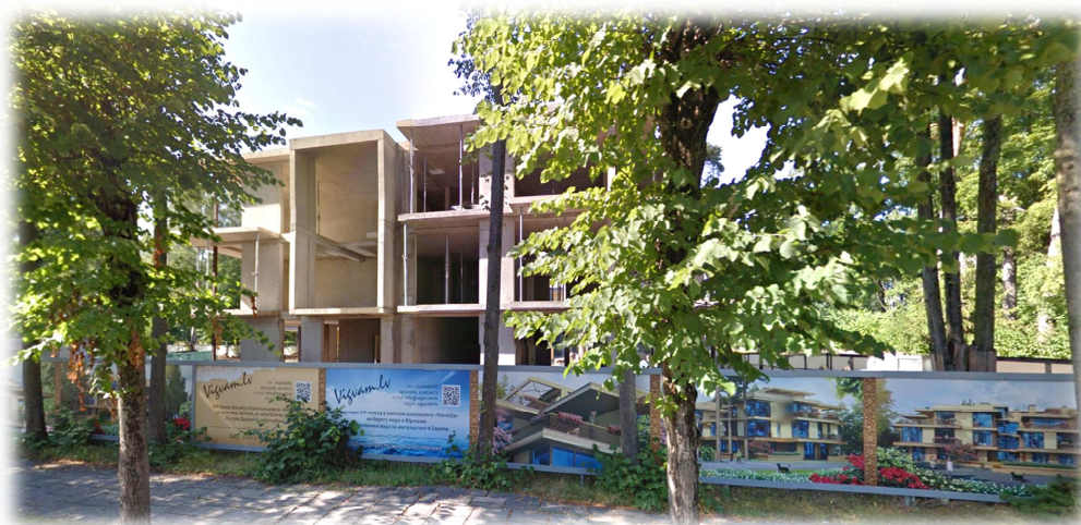
Blakus zemesgabālā Dzintaru prospektā 23, Jūrmalā notiek būvniecība saskaņā ar apstiprināto detālplānojumu.
