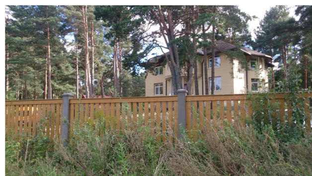
Esošā jaunbūve, skats no Bolderājas ielas
