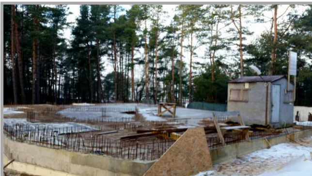
9.Attēls. Detālpārplānojuma teritorijas ziemeļu daļā uzsāktie būvdarbi „Viesu nama- viesnīcas” būvniecībai.
