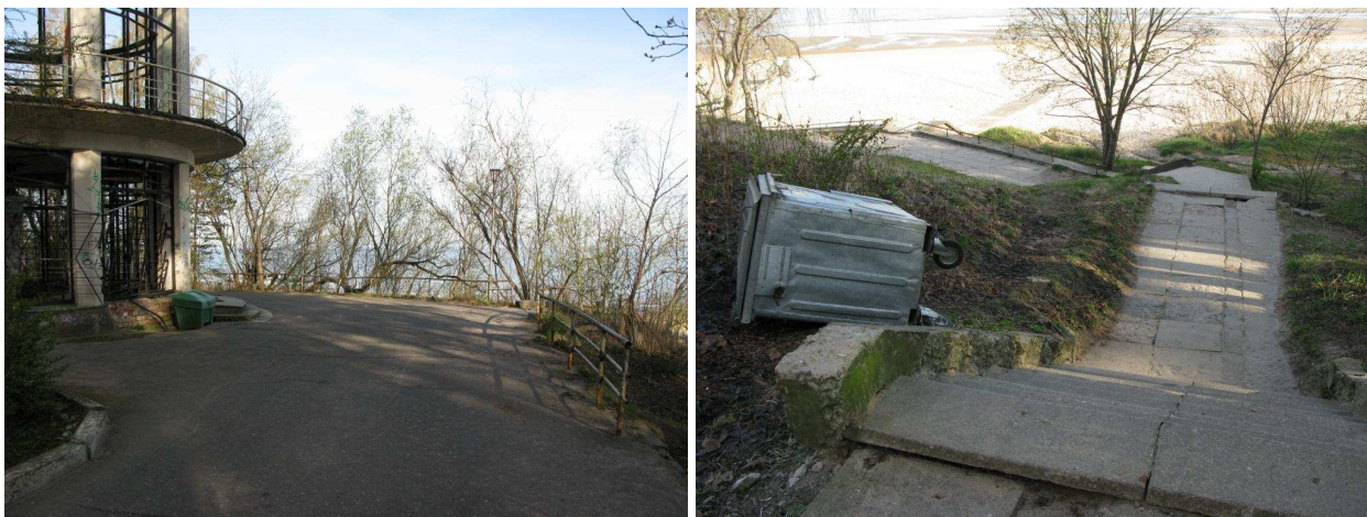
26., 27.attēls. Esoša skatu platforma/laukums Ērgļu ielas galā un kāpnēs līdz pludmalei.
