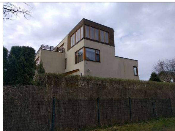
Esošā apbūve Braslas ielā 2B, Jūrmalā, skats no Braslas ielas posma, pie detālplānojuma teritorijas ziemeļu robežas
