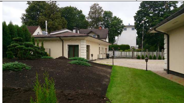
Rekonstruētā saimniecības ēka
