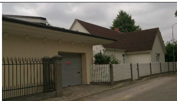
Rekonstruētā saimniecības ēka, skats no Peldu ielas
