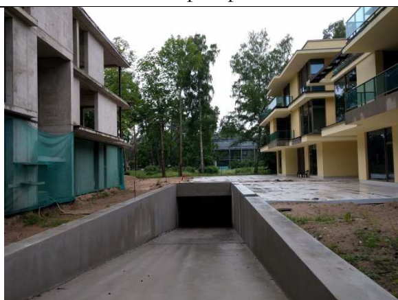
Izbūvētā iebrauktuve pazemes autostāvvietā
