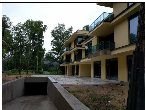
Ēkas būvniecības stadijā
