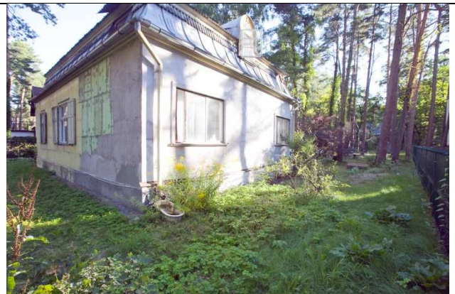
Ēkas pagalma fasāde (dienvidu daļā), vietām tā ir padomju laikā siltināta, daļēji apmesta
