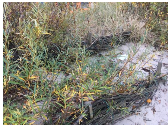
22.attēls. Piemērs Priekškāpas stiprināšanai ar kārkļu zaru pinumu.
