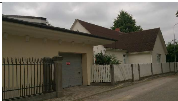
Rekonstruētā saimniecības ēka, skats no Peldu ielas
