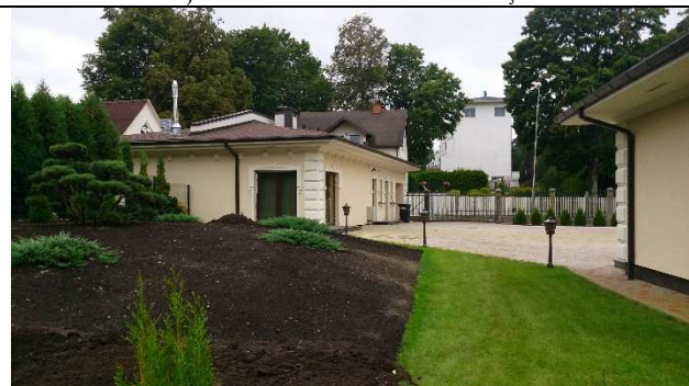
Rekonstruētā saimniecības ēka
